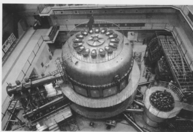
图 1 EAST 超导托卡马克装置
